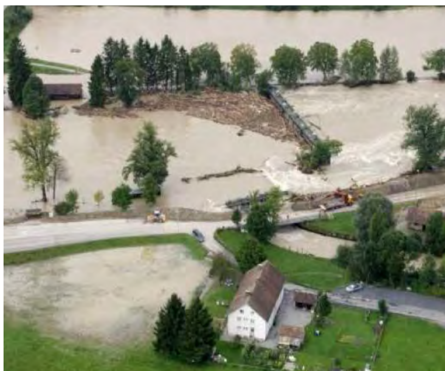
Das grosse Hochwasser von 2005 richtete entlang der Kleinen Emme und der Reuss Schäden in der Höhe von 345 Millionen Franken an.
