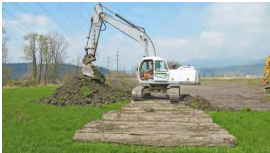
Die Erde vom Aushub wird für die Bodenverbesserung der Landwirtschaftsflächen verwendet. Auf dem Bild: Der Bagger verteilt den Humus. (Beispiel Bodenverbesserung Linthebene)
