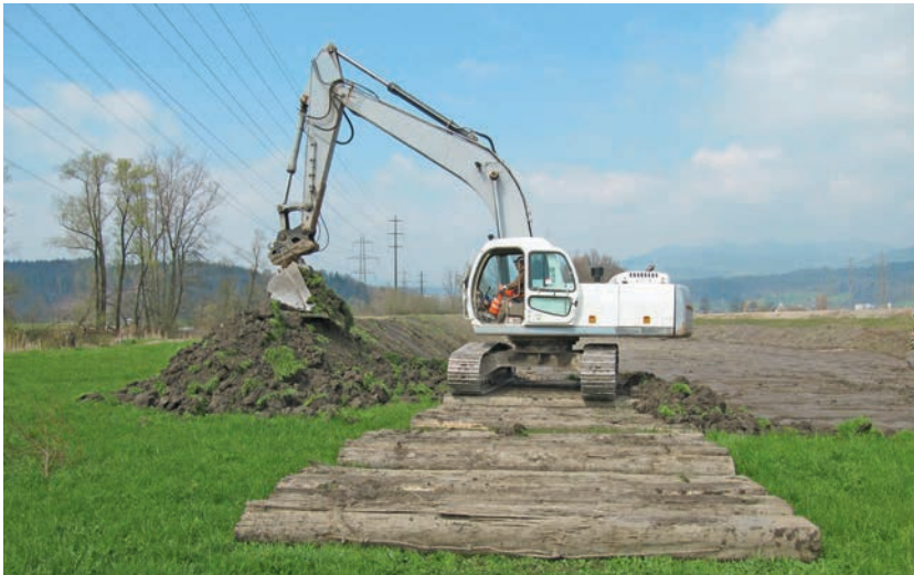
Die Erde vom Aushub wird für die Bodenverbesserung der Landwirtschaftsflächen verwendet. Auf dem Bild: Der Bagger verteilt den Humus. (Beispiel Bodenverbesserung Linthebene)
